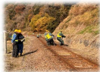
(軌道修繕工事)
