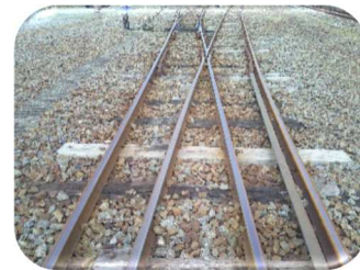
(分岐枕木交換)
