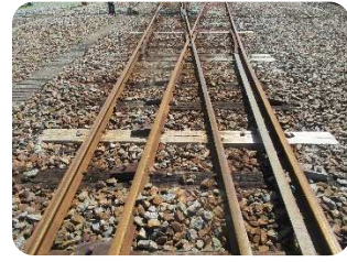
(分岐枕木交換)
