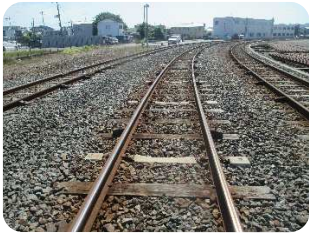
(レール交換小名浜駅構内)
