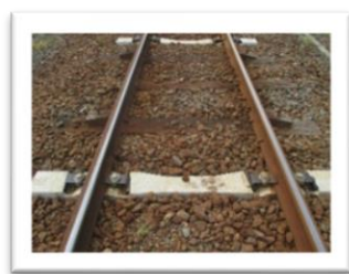
(37k用PCマクラギ交換)
