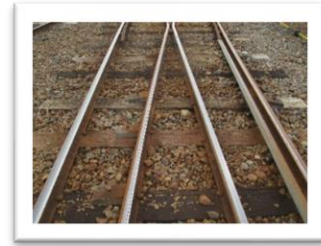
(分岐枕木交換)
