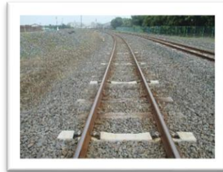
(50kN用PCマクラギ交換)
