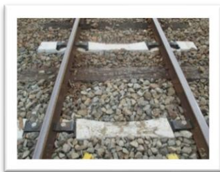
(30k用PCマクラギ交換)
